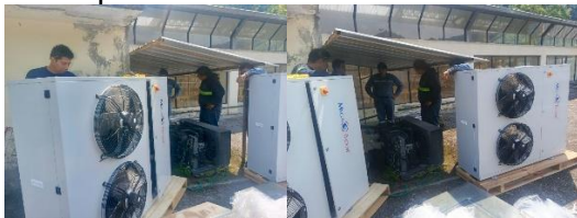
Verificación de los equipos y repuestos utilizados para rehabilitación de los cuartos fríos del camal municipal de Méndez
